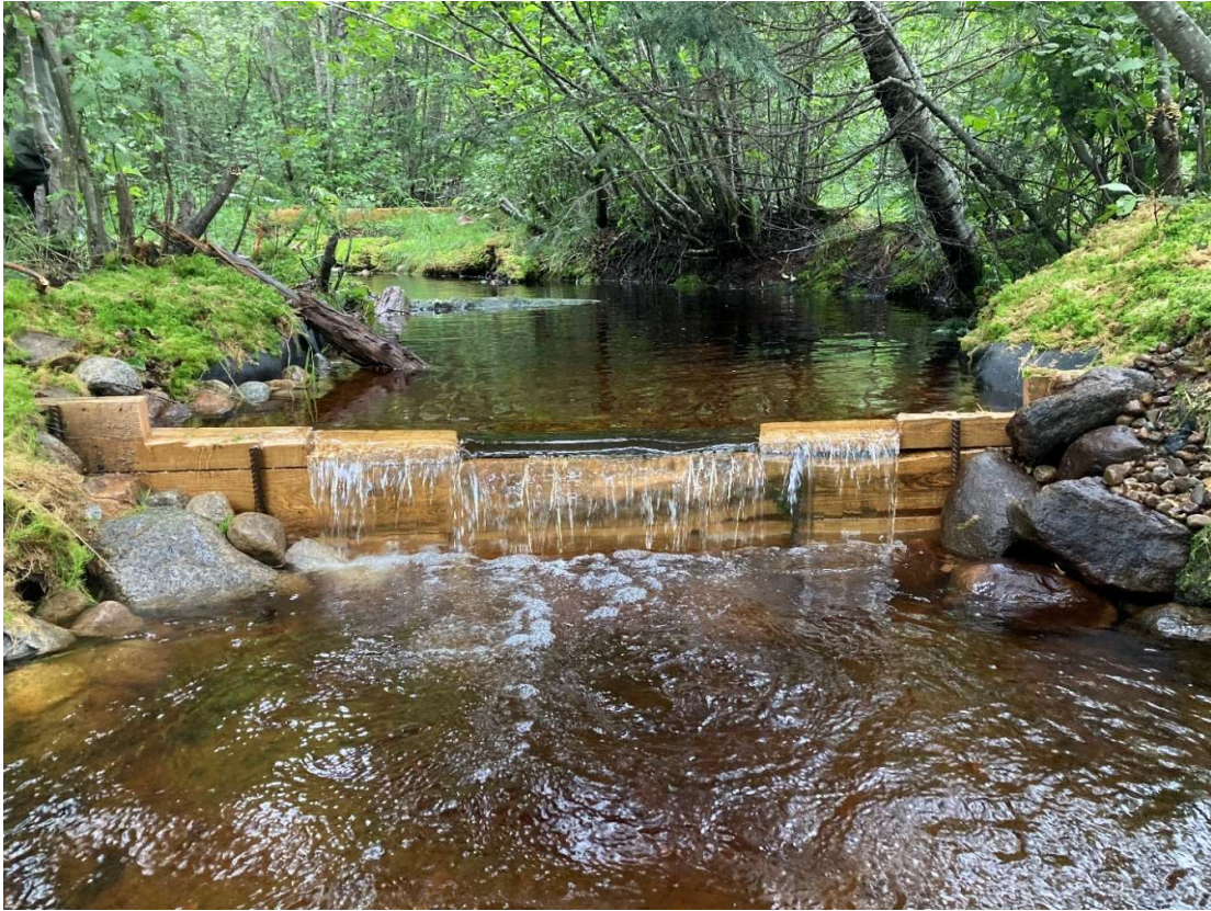
Figure 1. Aménagement d'un seuil en pruche au tributaire du lac la Salle (tri-Roy), saison 2020.
